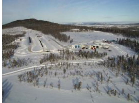
Winter-Teststrecke DExWin® Druckluftbehälter Winter Testing Track DExWin® Air Pressure Vessel
